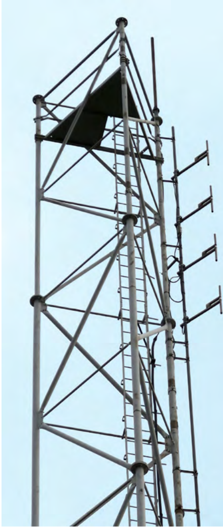
Fig. Quatre dipôles DAB+ large bande, couplés en réseau, sur un pylône autoportant.
